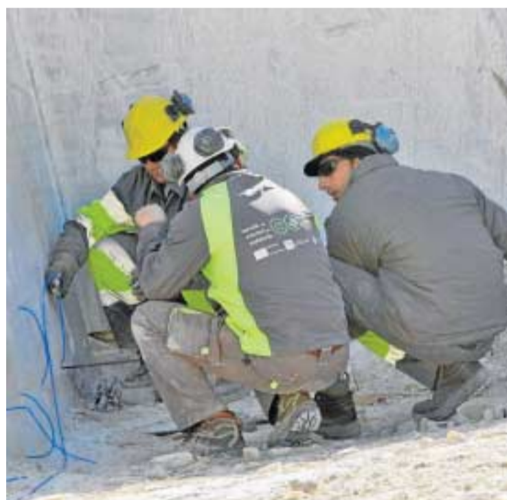
Operarios preparando el explosivo para ejecutar una voladura.
